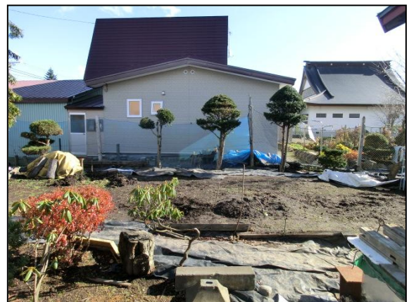
敷地北西側から
